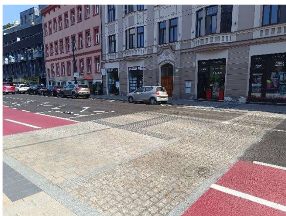
Obr. 5: Priestor pri bábkovom divadle a Wesselényiho záhrade pred a po rekonštrukcii.
