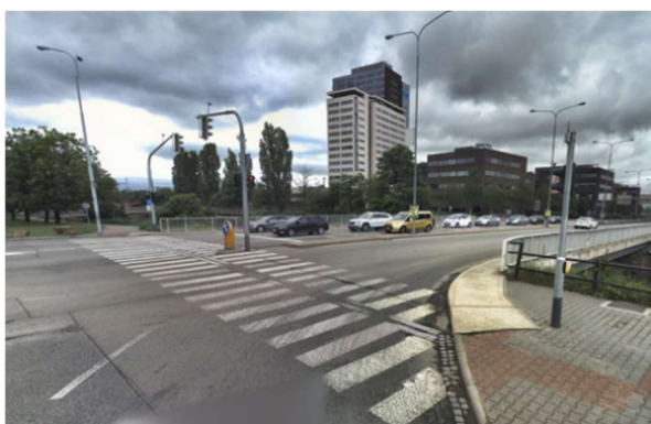
Obr. 4: Přechod přes ulici Heršpickou (2020)
