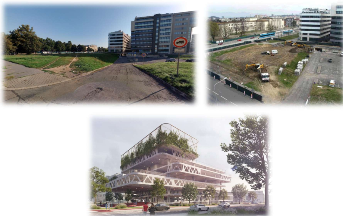
Obrázek 32 Parkovací dům – původní stav, probíhající stavba, vizualizace finálního stavu
