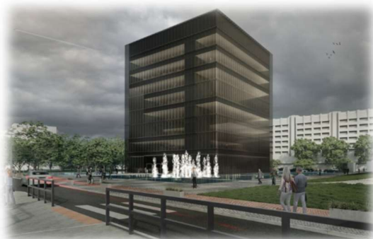
Obrázek 34 Moravskoslezská vědecká knihovna - původní stav, probíhající stavba, vizualizace finálního stavu
